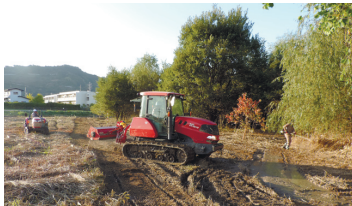
アシが生い茂っていた第3工区は、ヤンマーの協力で農地に
