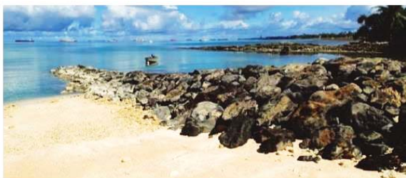
完成後の突堤
