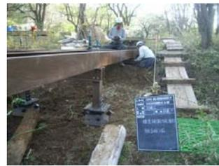
※構造型木道の構造部(支柱・大引・根太)の長寿命化の為にGRPを使用。
