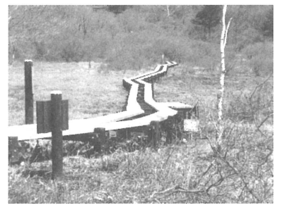
事例1 C-LESS基礎工法を用いた木道
