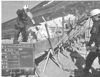
⑥ スパイクフレーム工法
