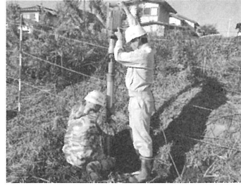
④ 鋼管杭基礎の施行
