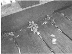
写真1 床板目地に土砂が堆積、雑草が繁茂している。腐朽しやすい状況
