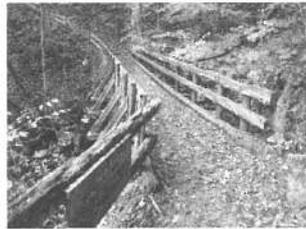
写真2 歩行時に振動を確認。構造部材の劣化が進み危険な状態(通行制限を実施)
