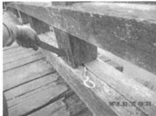
写真3 突刺診 地覆と高欄柱の仕口部で内部の劣化が確認された
