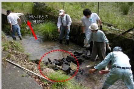
大規模の雨で破壊される程度の水制
