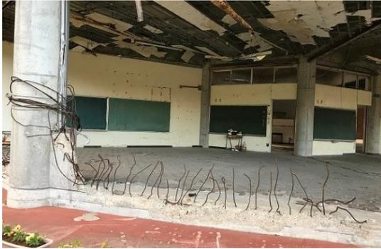
鉄筋がむき出しのコンクリート壁
