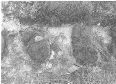
ヤシ土嚢の間に植生が回復
