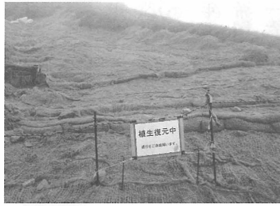
植生基盤として設置したヤシロール
