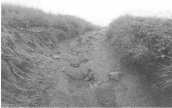
侵食部にフィットするヤシ土嚢
