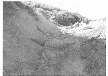
土砂で覆うヤシ土嚢の踏圧対策
