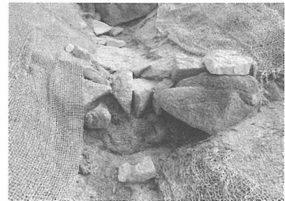
損傷した石組をヤシ土嚢等で補修
