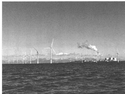
洋上風力発電施設(秋田県)
