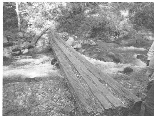
写真1 改修前の五頭山の木橋
