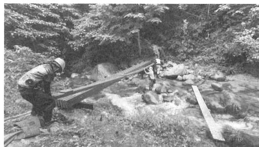
写真2 グラスランバー製主桁の施工状況
