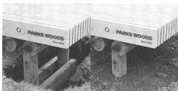
写真3 コンクリート基礎を使用しない工法
